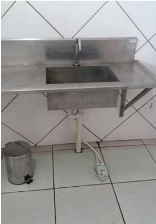
Figura 43. Pia para lavação das mãos com acionamento nos pés. Casa de extração mel Foto: Associação Apícola 25 de julho, São Carlos
