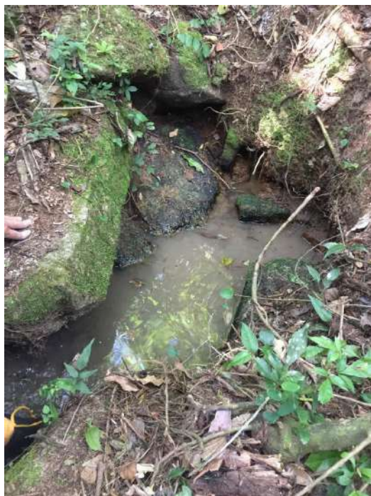
Figura 3. Escolher uma nascente perene e preparar o local para instalação da proteção. Limpar o local de captação de água. A instalação deve ser feita manualmente ou, excepcionalmente, com máquina de forma a mobilizar o mínimo possível o solo
