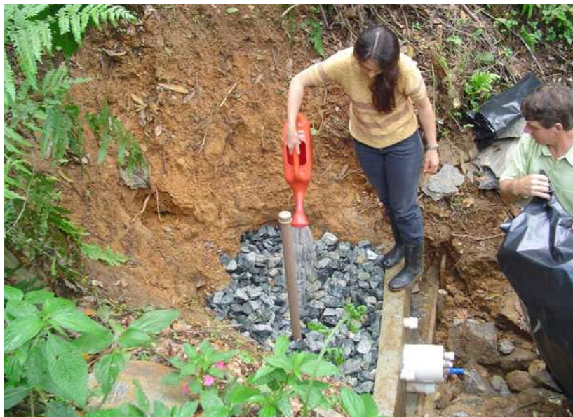
Figura 17. Realizar a desinfecção do leito filtrante antes do fechamento com lona plástica
