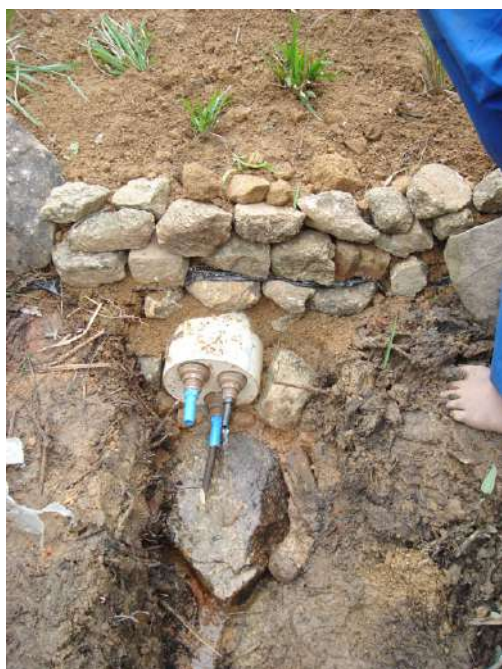
Figura 9. Instalar o tubo de PVC, seguindo os mesmos passos do Modelo Caxambu com tubo de concreto na posição horizontal
