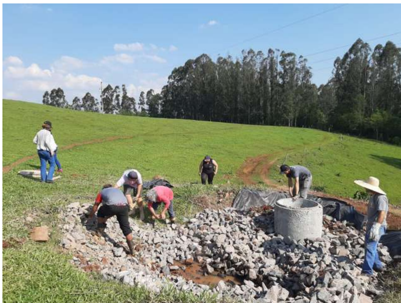
Figura 29. Após colocação das pedras maiores, cobrir as pedras com brita nº 2
