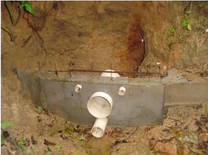
Figura 14. Aguardar a secagem e em seguida realizar a remoção da caixaria
