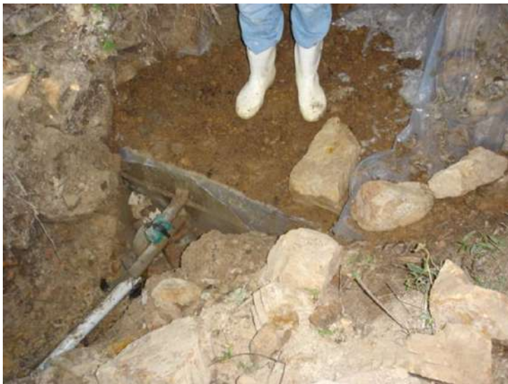
Figura 34. Após a colocação das pedras, cobri-las totalmente com lona plástica, deixando livre a parte frontal com as saídas de água; cobrir a lona plástica com uma boa camada de solo
