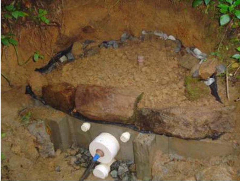
Figura 19. Cobrir com pedras e solo firme que devem ser bem colocados para evitar entrada de insetos e outros animais, como roedores, cobras, rãs, etc.
