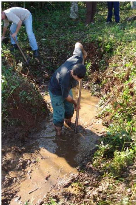
Figura 23. Realizar a limpeza do local, com a retirada de solo e materiais orgânicos. Deve ser feita manualmente ou, caso necessário, com o uso de máquina, de forma a mobilizar o mínimo possível o local da fonte até atingir uma camada impermeável e evitar a “fuga” da água.
