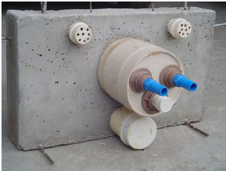
Figura 11. Montagem da estrutura: Parte frontal da proteção com 2 canos ladrão – 50mm, abaixo tubo de limpeza – 100mm e tubo captação com duas saídas – 25mm e 1 limpeza 40mm
