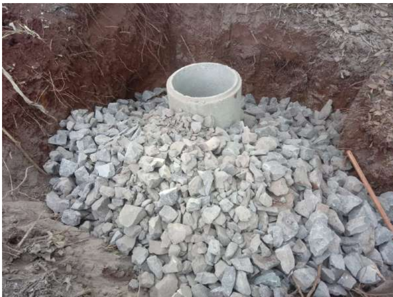
Figura 28. Colocar pedras-ferro (rachão de basalto) previamente limpas. As pedras maiores no fundo e menores acima. O espaço entre as pedras deve permitir a manutenção do fluxo natural de água existente
