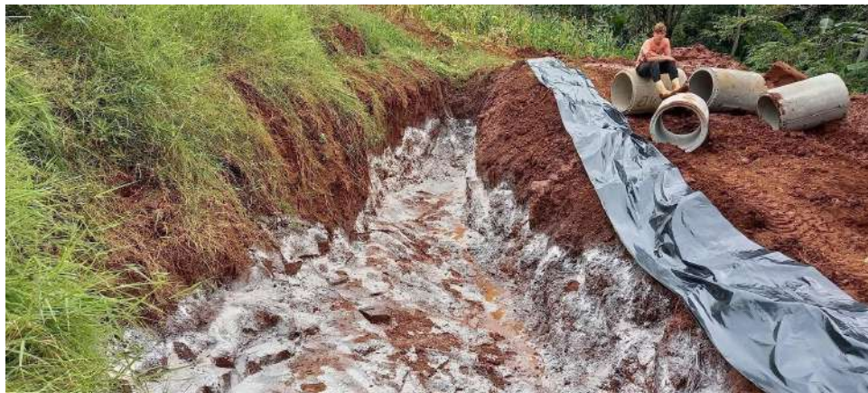
Figura 25. Detalhe da distribuição da cal hidratada. Por possuir características coagulante, adensante, precipitante e neutralizante de pH, a cal ajuda a separar os sólidos que estão na água, facilitando a decantação e contribuindo para a remoção de impurezas
