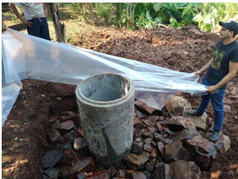
Figura 30. Cobrir todo o local no entorno do tubo com lona plástica nova, limpa e resistente para evitar infiltrações e contaminações da fonte de água
