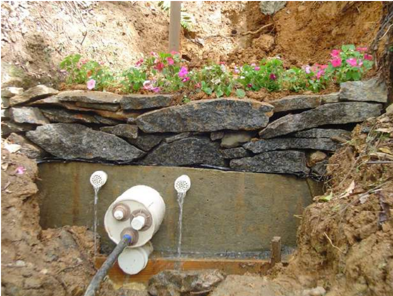
Figura 20. Após o término da proteção, se necessário, abrir valas nas partes superior e lateral da nascente para evitar a entrada de enxurrada com sedimentos provenientes de erosão no interior da fonte
