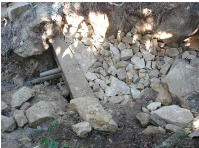
Figura 33. Preencher o local com pedras-ferro (pedras-de-mão) até cobrir totalmente a fonte na altura da estrutura em alvenaria
