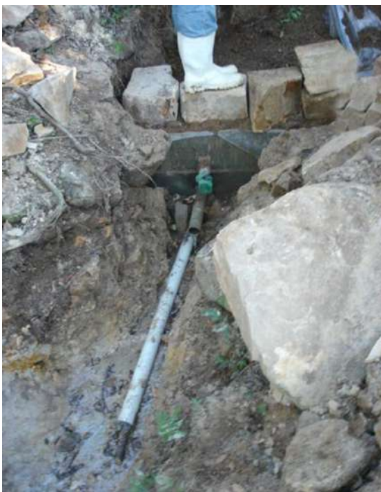
Figura 35. Finalizar a proteção com pedras e recompor a vegetação em torno da nascente
