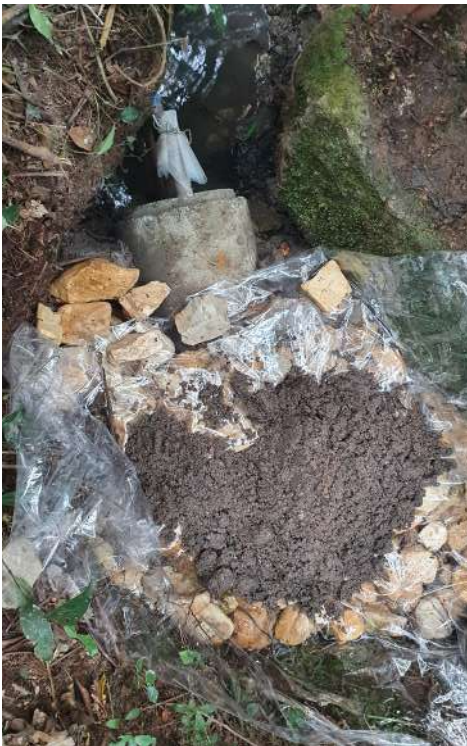
Figura 7. Instalar uma lona de proteção após a colocação das pedras e cacos, tendo cuidado de cobrir tudo e evitar de cobrir a parte frontal do tubo. Finalizar com a colocação de solo sobre a lona plástica e recomposição do local
