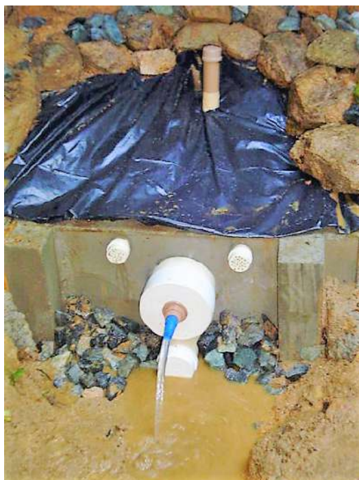
Figura 18. Instalar a lona plástica sobre as pedras na fonte
