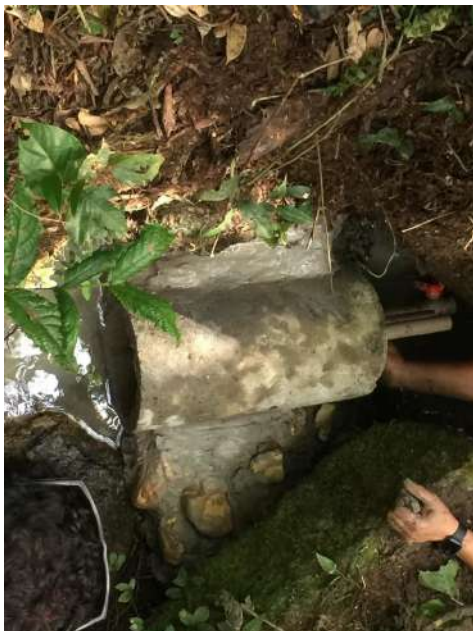
Figura 4. Construir a base onde será instalado o tubo na posição horizontal e assentar o tubo nivelado usando massa de barro ou cimento – conforme o local, proteger com pedras maiores a entrada da boca do tubo
