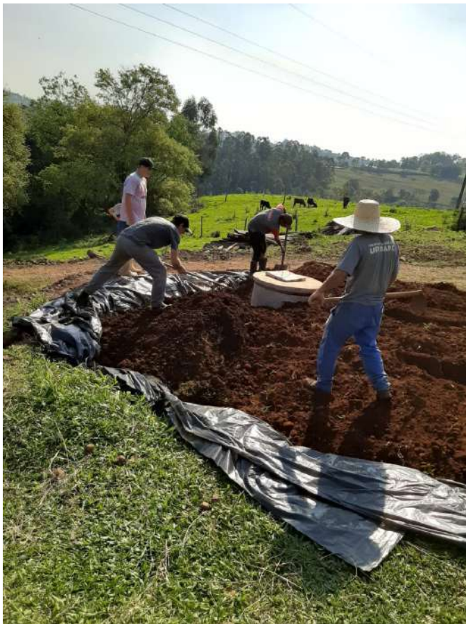
Figura 31. Sobre o tubo deverá ser colocado uma tampa de concreto para impedir a entrada de agentes contaminantes. Colocar uma camada de solo de boa qualidade sobre a lona plástica para posterior recomposição da vegetação
