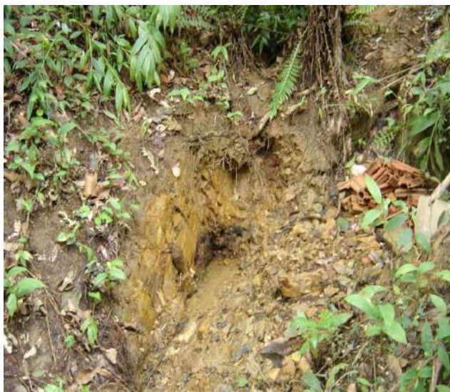
Figura 12. Limpe o local de captação da água. Deve ser feito manualmente ou, excepcionalmente, com máquina de forma a mobilizar o mínimo possível o solo
