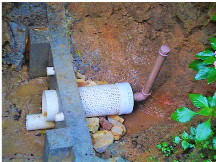
Figura 15. Instalar o cano de limpeza
