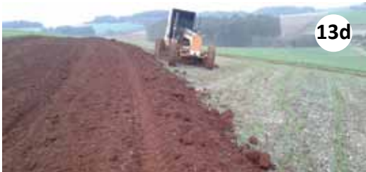
Figura 13d. Movimento de solo da parte de baixo do terraço; Figura 13e. Ajuste das irregularidades na crista do terraço
