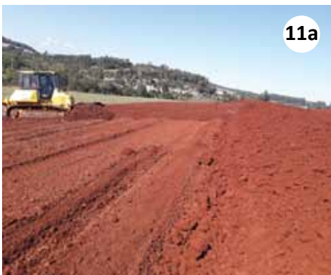
Figuras 11a e 11b. Movimentação de solo (de cima para baixo) em direção da linha de demarcação do terraço para formação do camalhão
