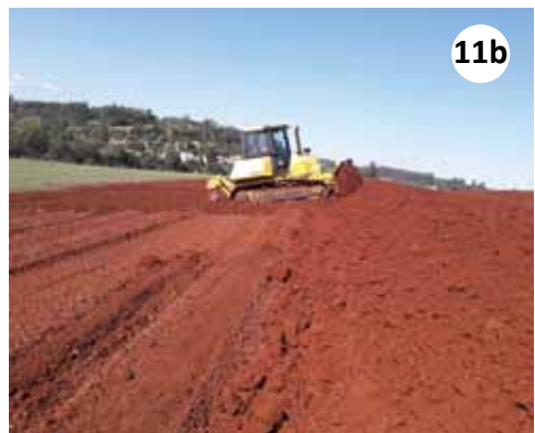
Figuras 11a e 11b. Movimentação de solo (de cima para baixo) em direção da linha de demarcação do terraço para formação do camalhão
