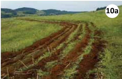
Figura 10a. Zona de corte escarificada, seguindo a marcação das estacas; Figura 10b. Trator de esteiras movimentando solo da zona de corte para a zona de aterro (sentido morro abaixo), construindo o talude do terraço
