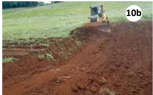
Figura 10a. Zona de corte escarificada, seguindo a marcação das estacas; Figura 10b. Trator de esteiras movimentando solo da zona de corte para a zona de aterro (sentido morro abaixo), construindo o talude do terraço
