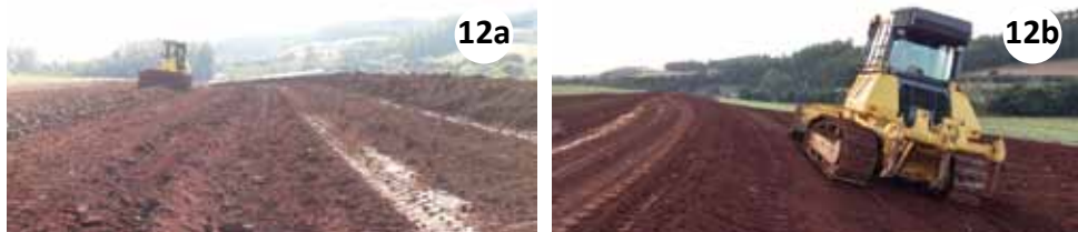
Figuras 12a e 12b. Acabamento longitudinal na zona de corte e aterro do terraço
