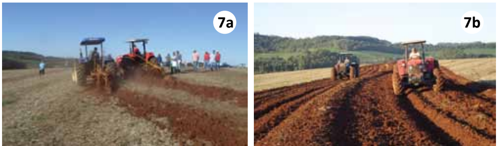
Figura 7a. Primeira série de passadas de tratores com arados de disco para a construção do camalhão do terraço; Figura 7b. Segunda série de passadas
