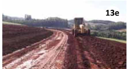
Figura 13d. Movimento de solo da parte de baixo do terraço; Figura 13e. Ajuste das irregularidades na crista do terraço
