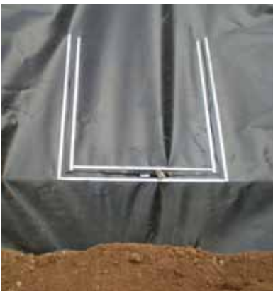
Figura 7. Porta tampão de acesso ao interior da cisterna com cadeado
