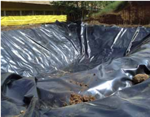
Figura 3. Disposição da manta em dia de sol quente
