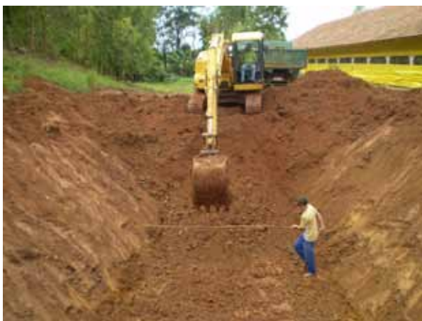
Figura 2. Escavação da cisterna
