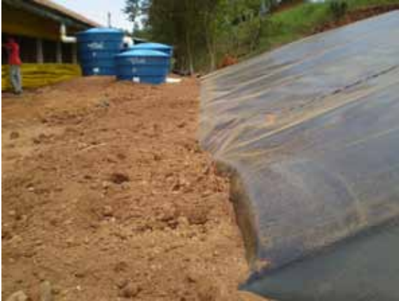
Figura 5. Fixação das bordas com terra
