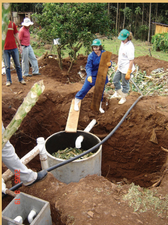
Figura 29. Sistemas de reator simples com bambu mais ciclo da bananeira
