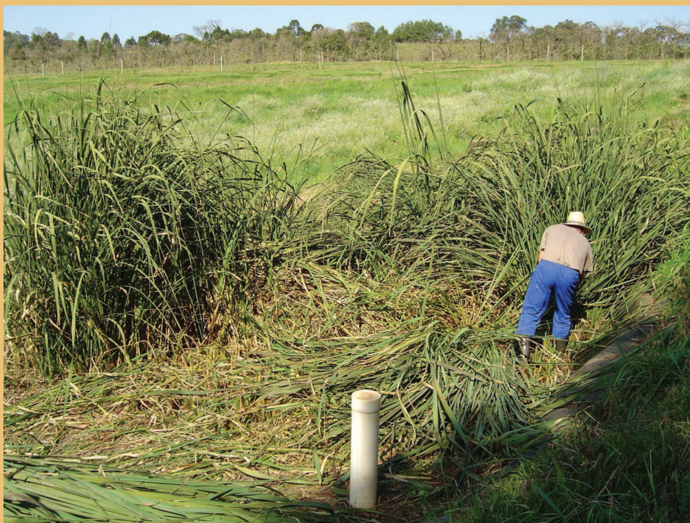
Figura 30. Sistema fossa séptica mais zona de raízes com ciclo da bananeira ou valas de infiltração
