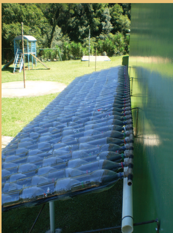
Figura 15. Modelo prático de aquecedor solar
