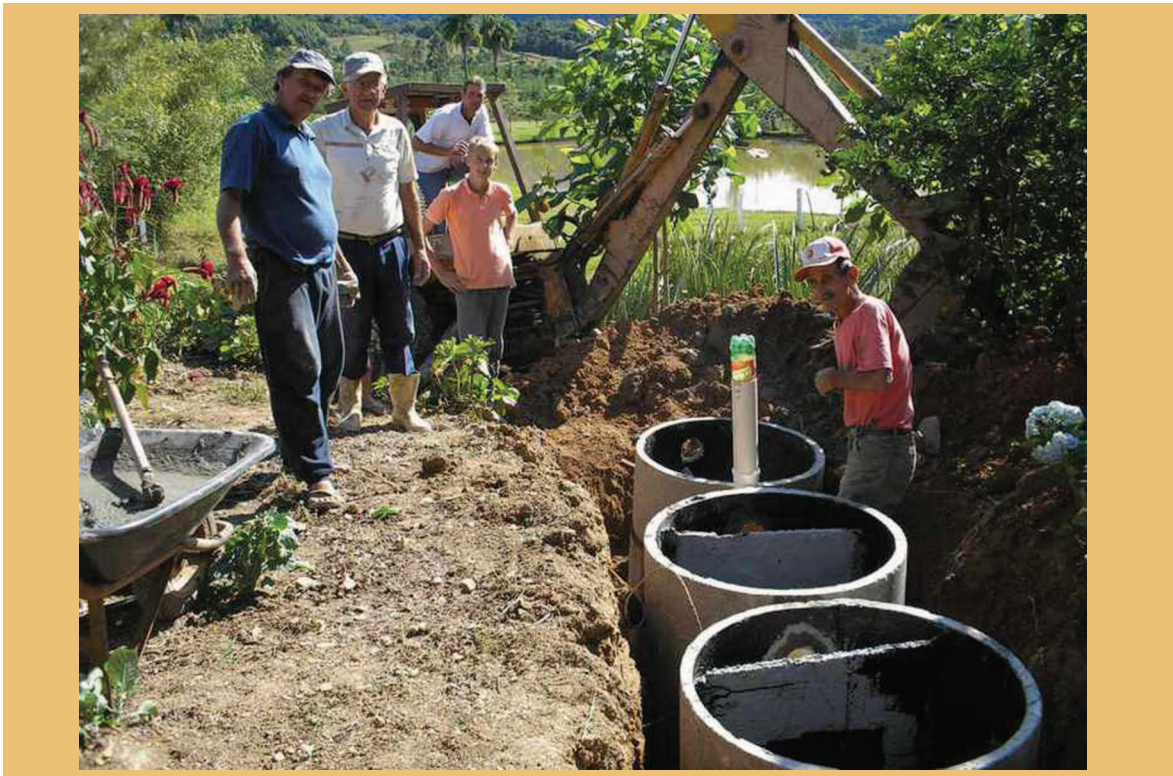
Figura 28. Sistema fossa séptica (câmaras em série) mais filtro com ciclo da bananeira
