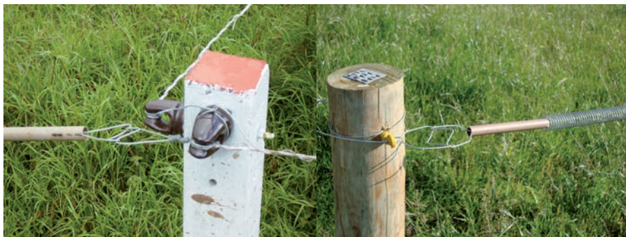
Figuras 31 e 32. Detalhe da instalação de porteiras
