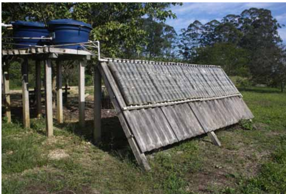
Figura 34. Aquecedor solar de garrafas PET
