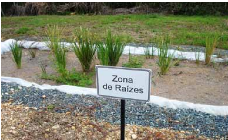
Figura 36. Tratamento de efluentes por zona de raízes
