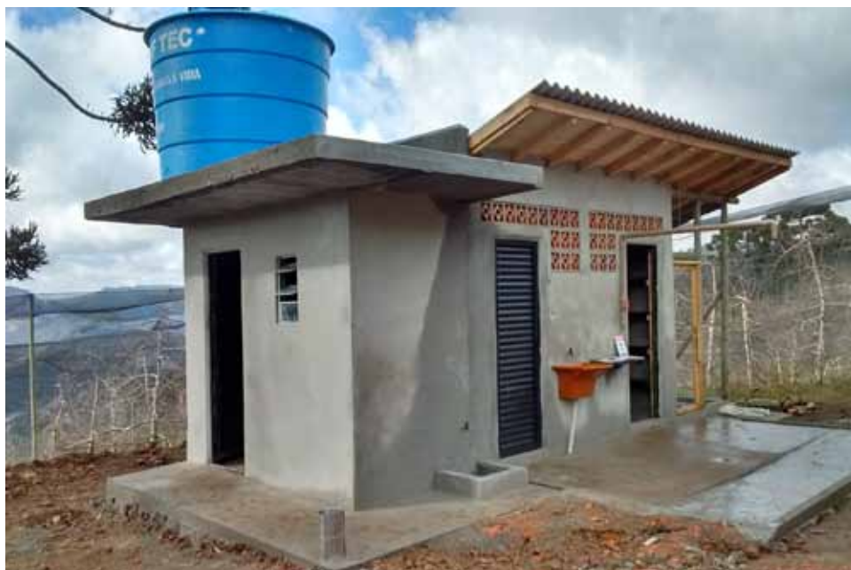
Figura 5. Depósito de embalagens de agrotóxicos e rampa de abastecimento de pulverizadores. Apoio financeiro do Programa SC Rural
