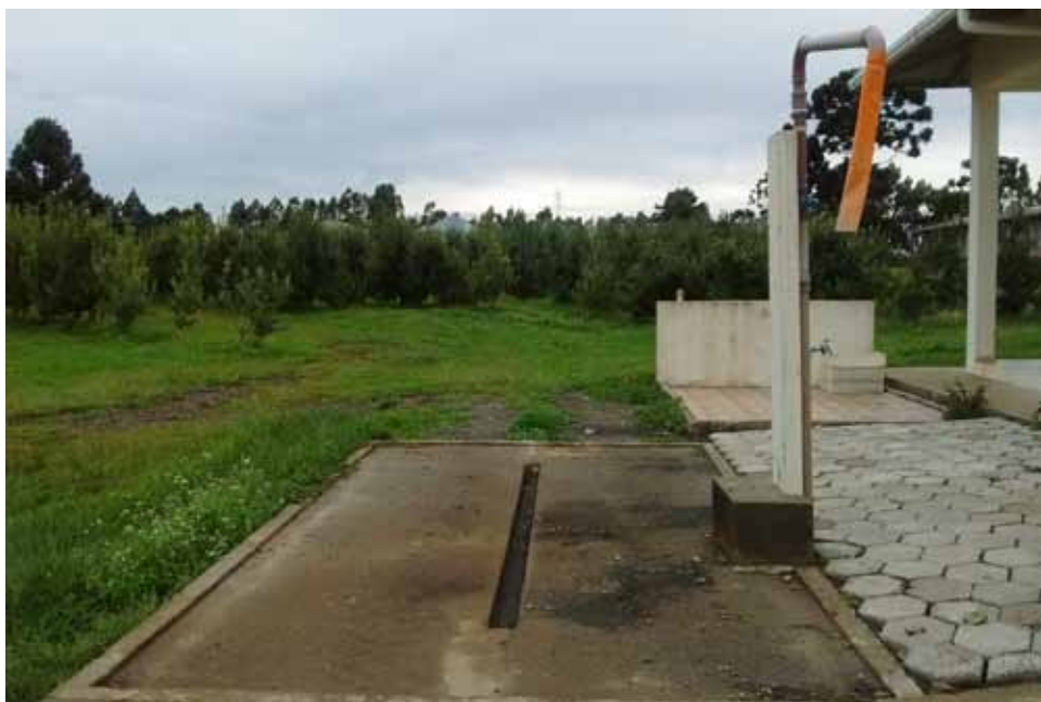
Figura 4. Rampa de abastecimento de pulverizadores
