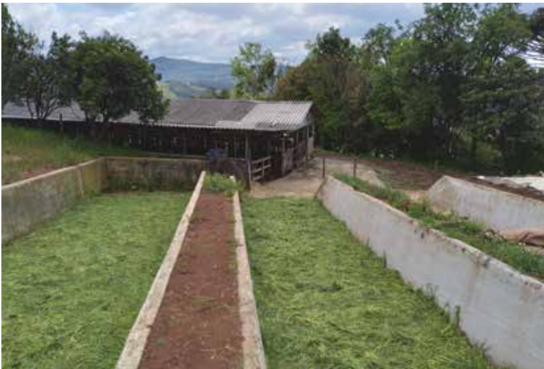
Figura 38. Detalhe do posicionamento correto do silo em relação ao estábulo
