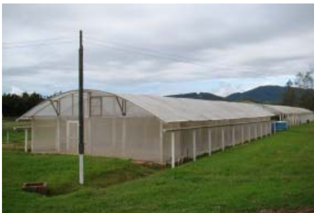
Figura 24. Abrigo de cultivo modelo Epagri/Estação Experimental de Itajaí provido de tela anti-insetos nas laterais e frontais e de calhas coletoras de água da chuva
