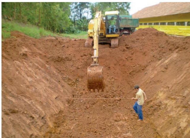
Figura 2. Escavação da cisterna
