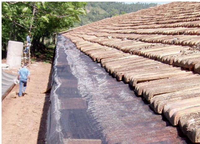
Figura 8. Telhado de captação com detalhe da calha em Pead revestida com “sombrite”
