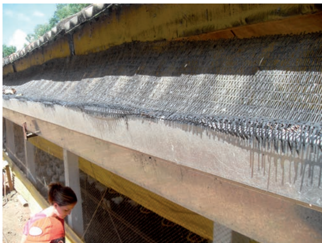
Figura 9. Calha de metal protegida com “sombrite”
