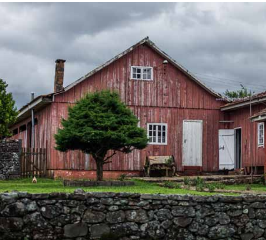
Figura 40. Casa da fazenda de gado e galpões em construção de madeira com taipas no entorno
