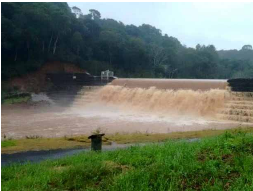
Figura 10. Barragem de contenção de enchente vertendo no parque de exposições do município de Concórdia
