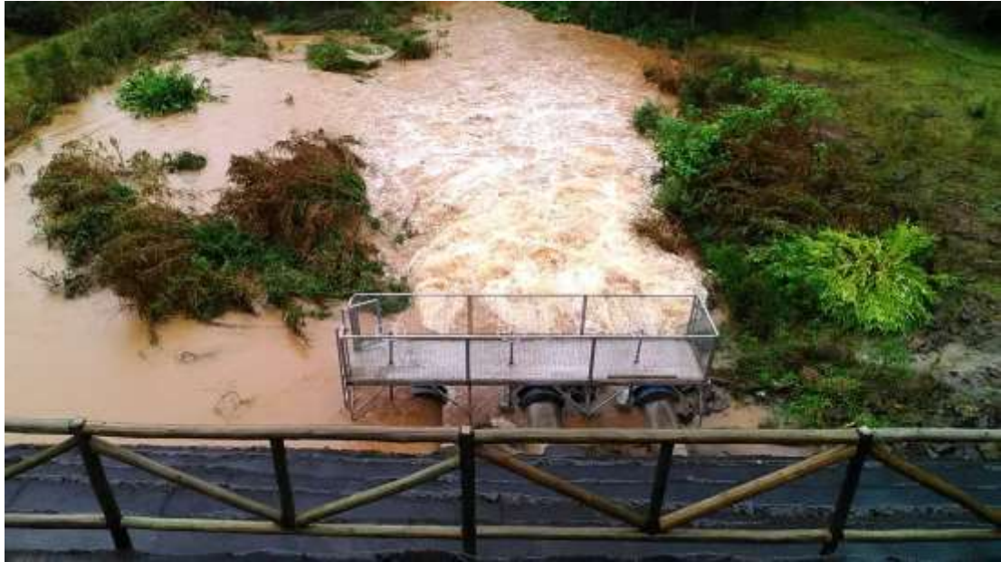
Figura 20 – Comportas da barragem de contenção de enchente de Concórdia – Fotografia: Miro Toldo – Prefeitura Municipal de Concórdia.
