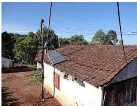
preto para absorver o calor solar e aquecer a água que passa pelo sistema, sai da caixa em temperatura ambiente que lentamente se eleva, retornando para a caixa para ser distribuída para chuveiro, pia ou sala de ordenha. O sistema visa, além da economia de energia elétrica, à reciclagem direta das embalagens dos produtos consumidos, revertendo em projetos socioambientais.
