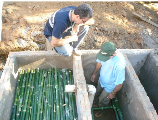
Figura 13. Sequência da instalação do sistema Gaudino
