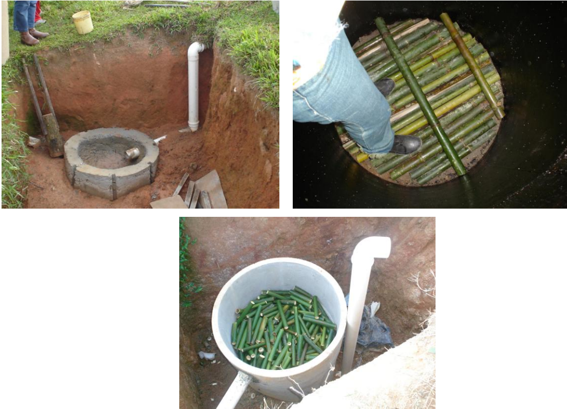
Figura 14. Sequência da instalação do sistema Reator Simples Unicamp
