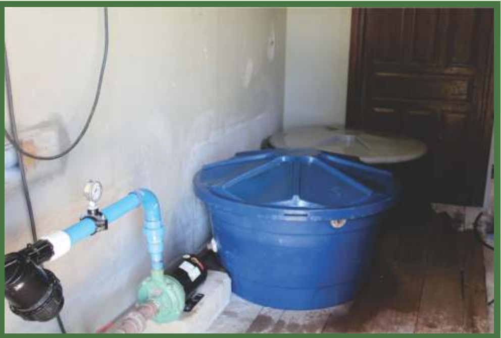
Figura 5. Tanques de mistura de adubos para fertirrigação, bomba e filtro de discos
