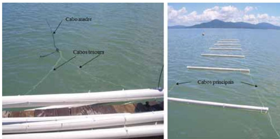
Figura 5. Instalação da balsa de cultivo no mar, mostrando detalhes dos cabos principal e tesoura, além do cabo madre que fixa a balsa de cultivo à poita ou à estaca
