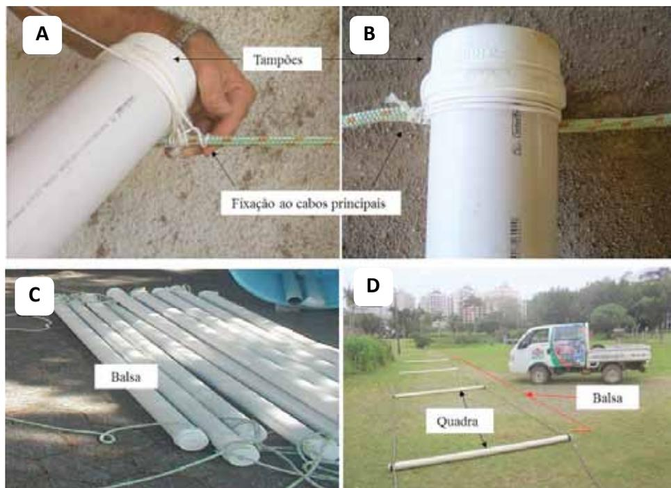
Figura 3. (A, B) Etapas da montagem de uma balsa de cultivo de algas construída com PVC 100mm, mostrando a fixação dos tampões e as amarrações ao cabo principal; (C) a balsa montada formando os módulos e (D) uma vista parcial da balsa de 100m esticada, com os diversos módulos
