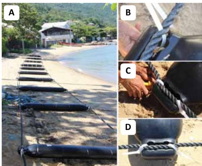
Figura 7. (A) Montagem de *longline* com flutuadores desenvolvidos para o cultivo de algas; (B) apresentando detalhes da abraçadeira: posicionada por entre a alma do cabo para impedir o deslocamento do flutuador; (C) fixada com uma volta dupla e tensionada firmemente com alicate; (D) posicionada em sentido diagonal ao cabo, sentido que confere melhor amarração entre corda e flutuador
