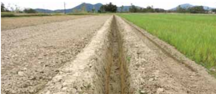
Figura 9. Canal de drenagem readequado
