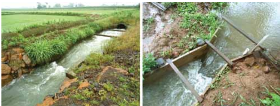
Figura 14. Calha Parshall (esquerda) e calha CTR com sensor de nível (direita) usadas para monitorar a vazão de irrigação em associações de irrigantes de Nova Veneza, SC
