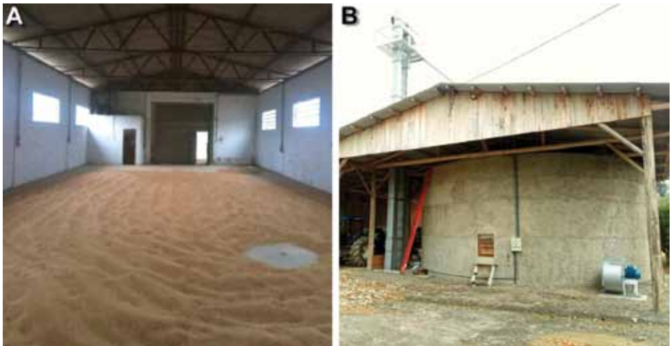
Figura 52. Estruturas de secagem natural (A) e estacionária (B) “projeto Armazenater, Emater – RS”
