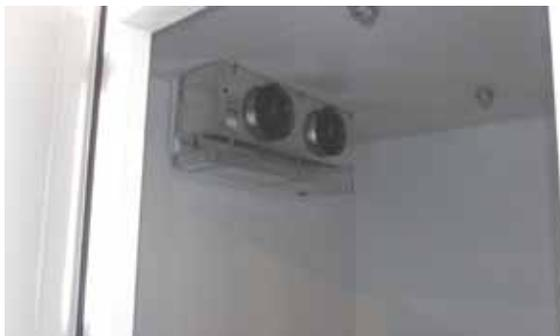
Interior da câmara de climatização com os equipamentos de controle de temperatura
