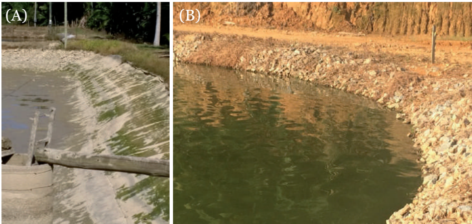
Figura 4. Diferentes proteções de talude utilizadas em Santa Catarina. (A) Proteção com lona; (B) Proteção com pedra brita 4 Fotos: Bruno Corrêa da Silva
