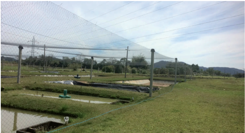
Figura 31. Tela de proteção à pássaros (50mm entre nó) utilizada na unidade de piscicultura da Epagri
