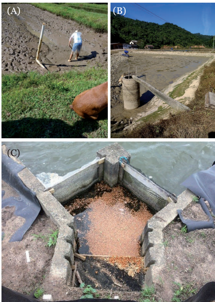
Figura 7. Diferentes tipos de drenagem dos viveiros. (A) Sistema de cachimbo; (B) Sistema de monge com tubo de concreto; (C) Comporta de concreto Fotos: Haluko Massago (A e B) e Bruno Corrêa da Silva (C)
