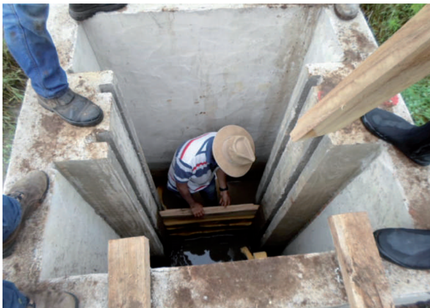
Figura 8. Monge com sistemas de stop-logs
