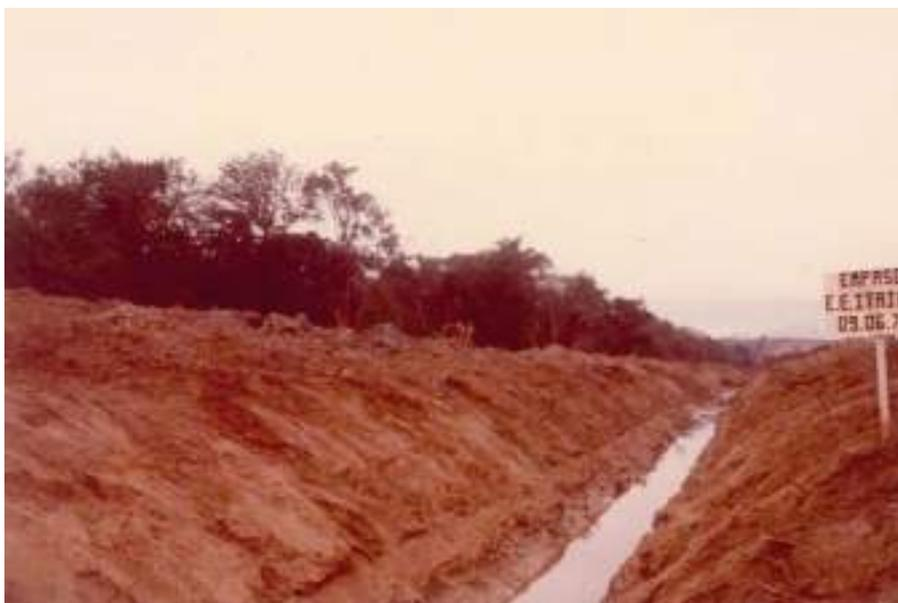
**Figura 75.** Construção de diques de contenção de cheias nos fundos da área da EEI
