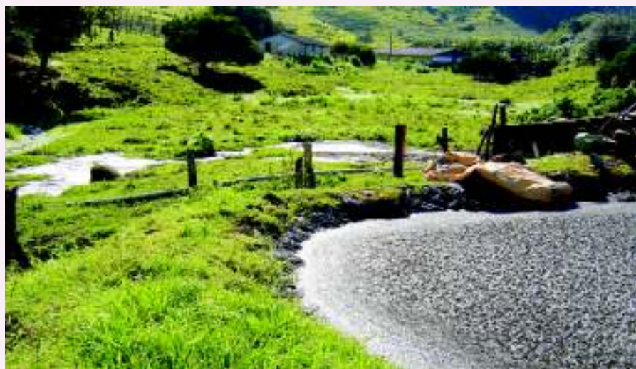
Sistema de tratamento inadequado, com revestimento de lona completamente deteriorada pela ação do tempo e risco de transbordamento de dejetos
