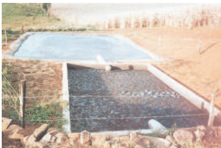
Figura 1 – Modelo de uma bioesterqueira no município de Videira, SC
