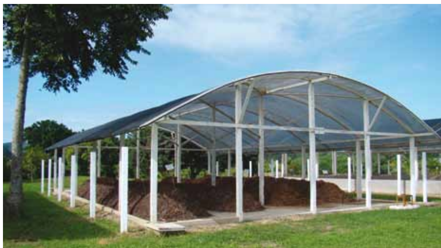
Figura 1. Leiras de matéria-prima em processo de compostagem em abrigos cobertos por polietileno e com piso de cimento
