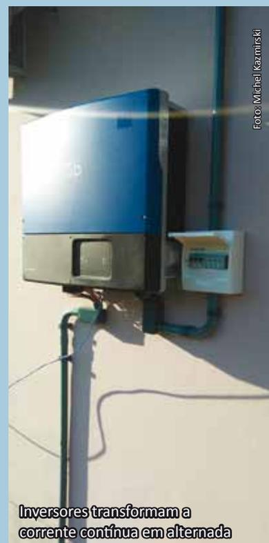
Inversores transformam a corrente contínua em alternada
