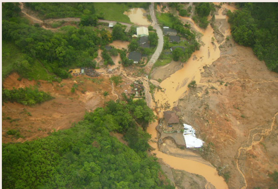
Ponte e estradas destruídas pela força das águas
