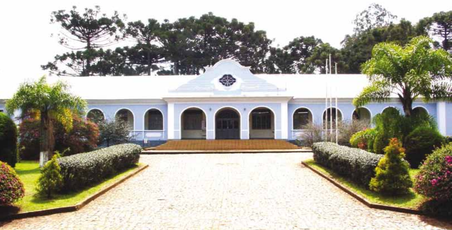
Figura 1. Prédio-sede da Estação Experimental de Caçador, com a copa de pinheiros de seu bosque de araucárias. O Prédio-sede da EECd é idêntico ao da Embrapa Florestas, de Colombo, PR
