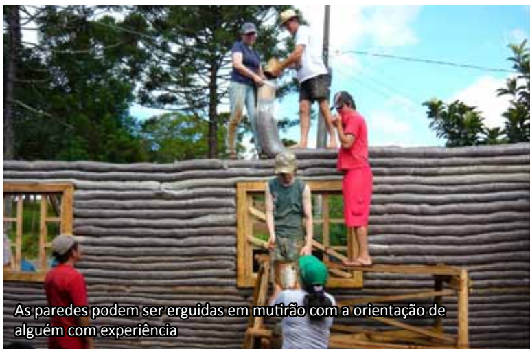
A técnica oferece conforto térmico e acústico e reduz o valor da obra em cerca de 30%
