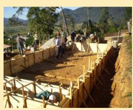
ser construída com tijolos, é preferível fazer em concreto armado com ferro, que, além de durar mais, diminui o risco de rachaduras e torna a impermeabilização mais fácil, evitando vazamentos", orienta Altamiro.
