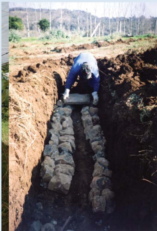
Canal com pedras no fundo do dreno para escoar a água do parreiral
