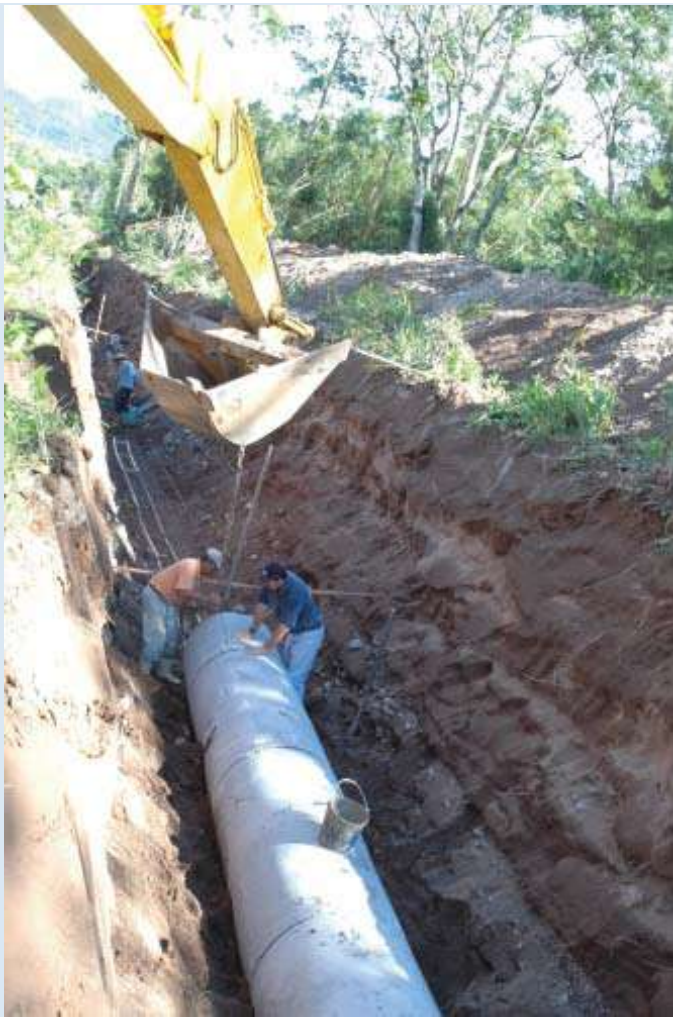
Colocação dos tubos de concreto no canal da Adinga
