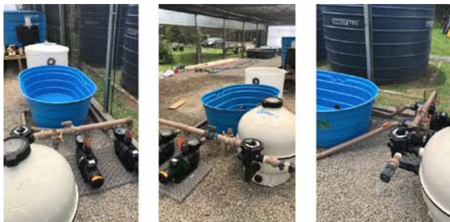
Figura 2. Instalação das unidades de tratamento de água. Foto: Luiz G. B. Peruch Figure 2. Water treatment units installation. Photo: Luiz G. B. Peruch
