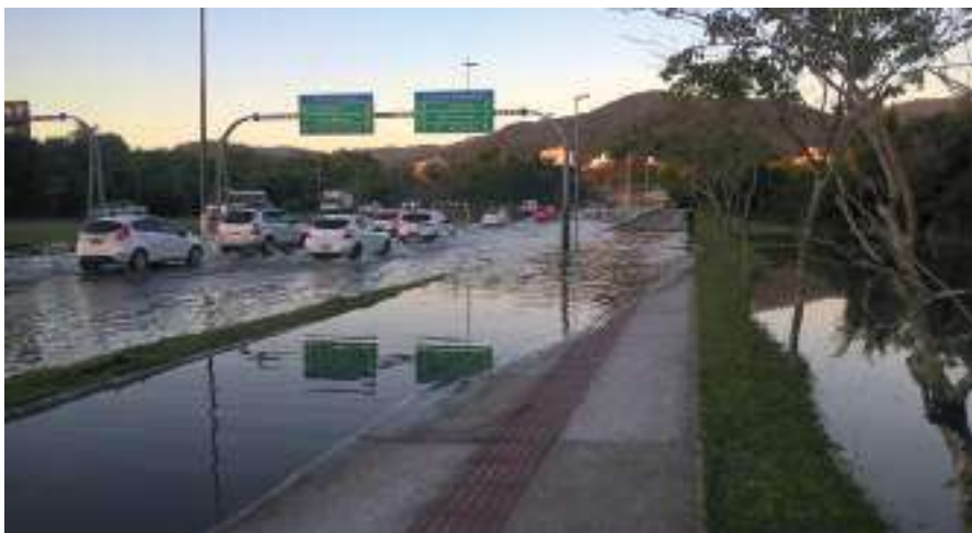
Figura 3. Inundação costeira da Avenida da Saudade – Florianópolis (7/7/2019 -17h20)
