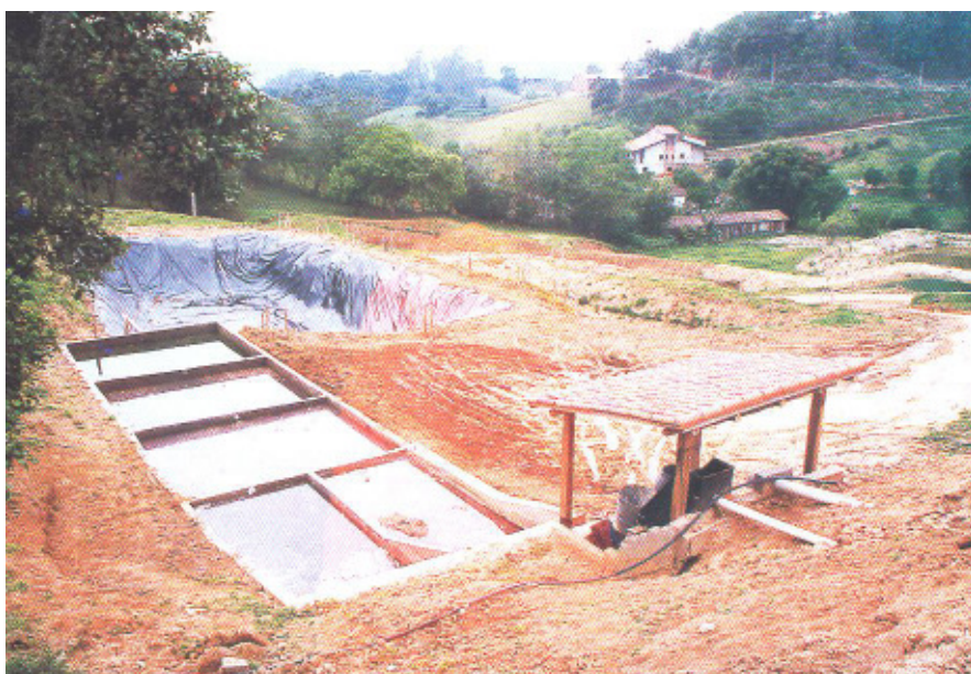
Caixas separadoras de tratamento de efluentes para abatedouros ou frigoríficos, uma das exigências da inspeção sanitária
