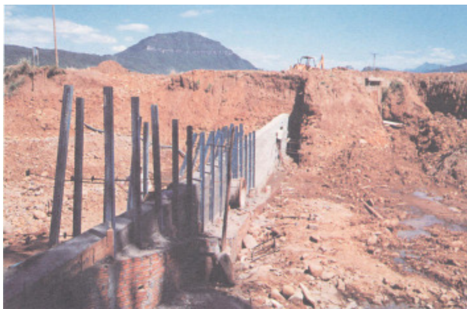
...a reconstrução é feita desviando-se as águas do rio São Bento
