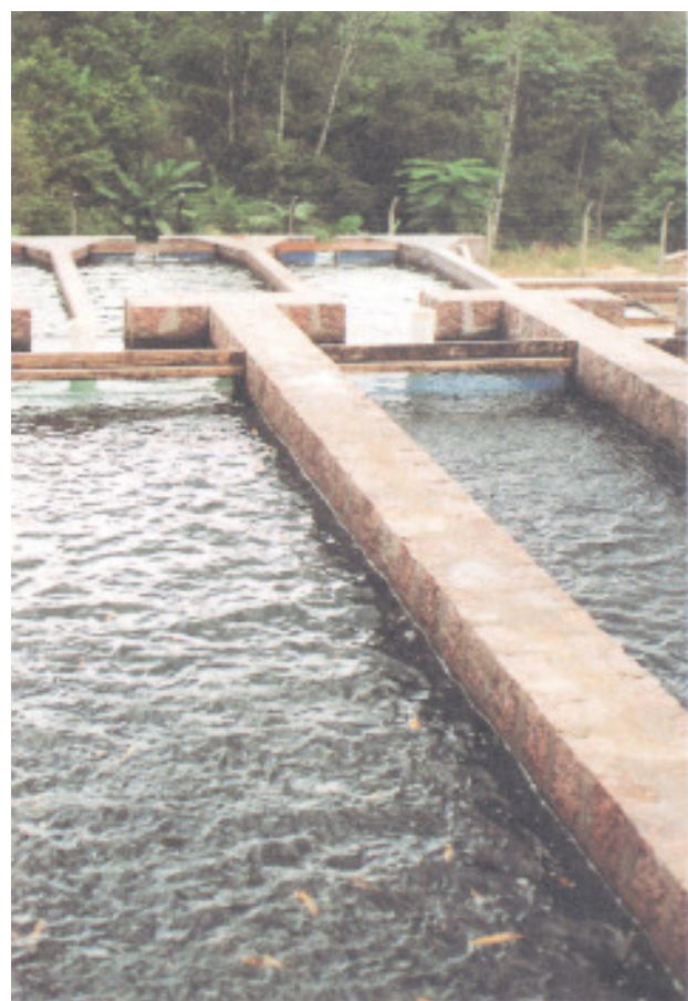
Tanques de pedra cortada: Charles Sievert
