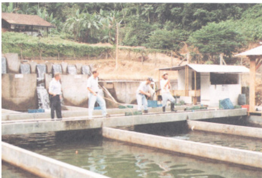
Tanques de concreto: William Sievert
