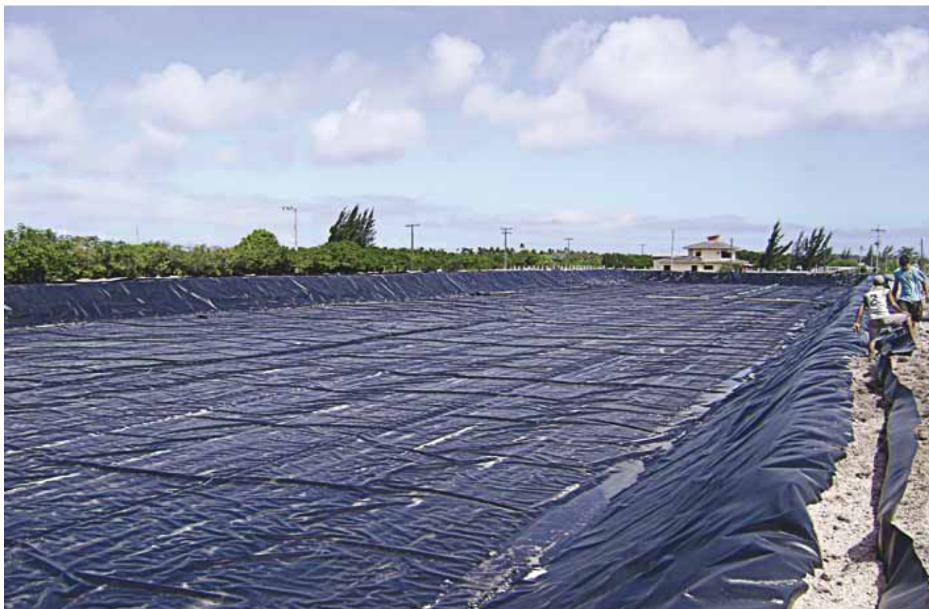
Figura 1. Revestimento do fundo do viveiro (0,6ha) com geomembrana PAD
