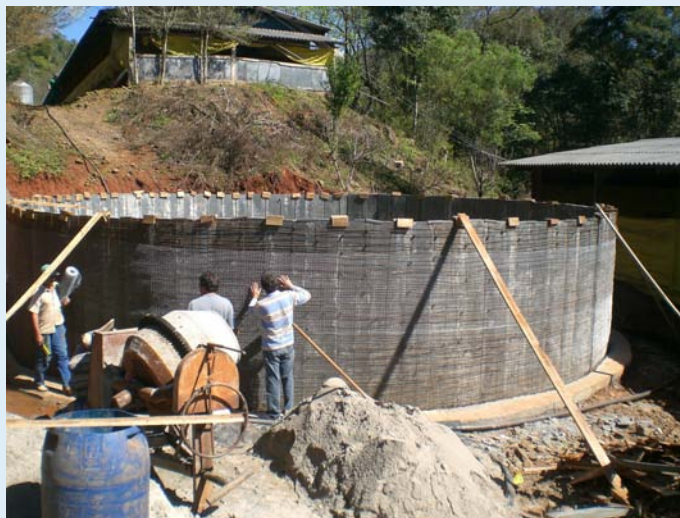
Cisternas de placas de ardósia e chapas de aço são baratas e fáceis de construir
